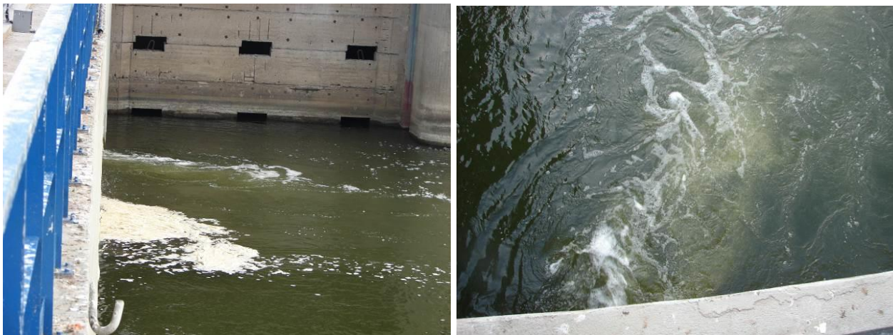
Fot. 23,24- Wylot wody z rurociągu wabiącego i przepławki
