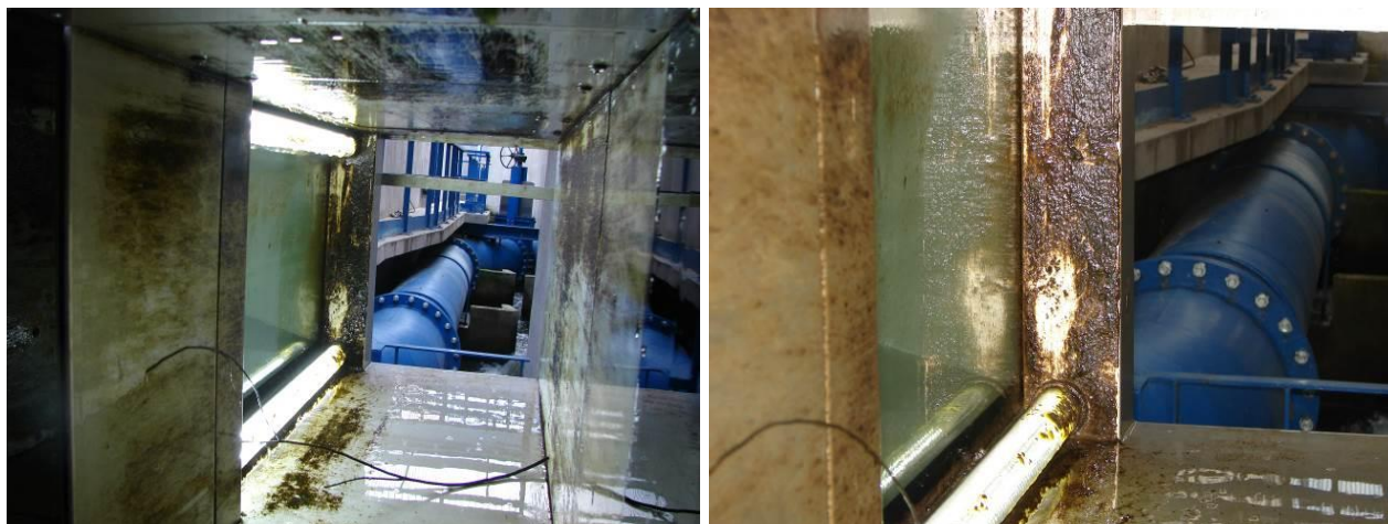
Fot. 17,18- Na zdjęciach widoczna „wnęka” lamp LED w fototunelu skanera, która wymaga zabudowy szybą lub pleksi.
